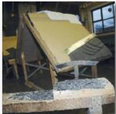
Arbeiten wie die Nachwuchshandwerker: Im BGZ lernten die Lehrer, wo die Tücken bei der Bedeckung eines Dachs liegen und auf welche Details es ankommt. Foto: Elmar Brandt
