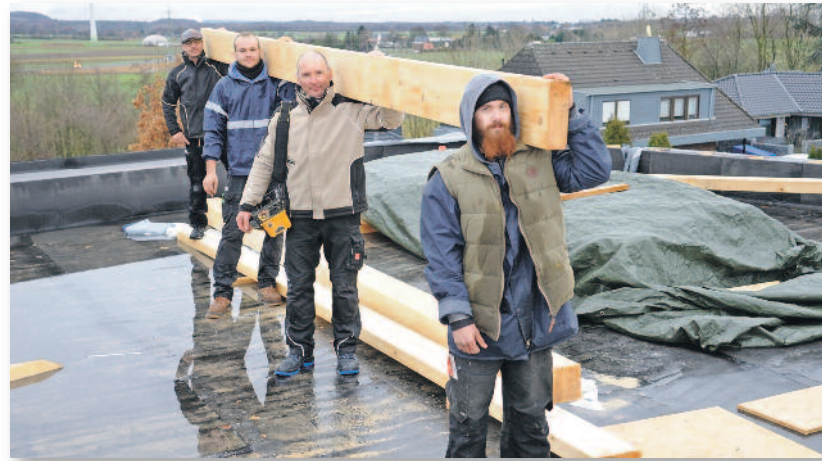
Zuerst Praktikum, jetzt unbefristet eingestellt: Loic Simonet aus Paris arbeitet bei Holzbau Herten in Aachen. Auf unserem Bild steht er gemeinsam mit seinem Chef Valentin Herten (hinten) sowie seinen Kollegen Tom Levecke und Michael Meder auf einem Dach. Foto: Doris Kinkel
