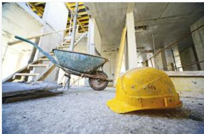
Erbringt der Bauherr seine Eigenleistungen nicht termingerecht und verzögert sich dadurch der gesamte Bauablauf, kann er eventuell sogar schadensersatzpflichtig werden.
