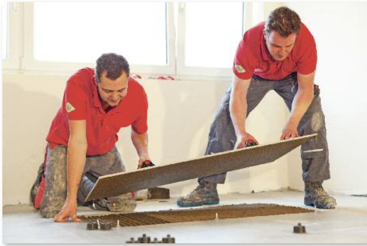
Besser mit Meister: Die Zulassungspflicht wird unter anderem auch für Fliesen-, Platten- und Mosaikleger eingeführt. Foto: amh-online.de
